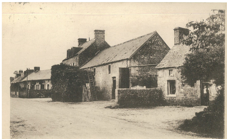
SAINT-MARTIN le GRÉARD. - La Maison Pessel et le Village
